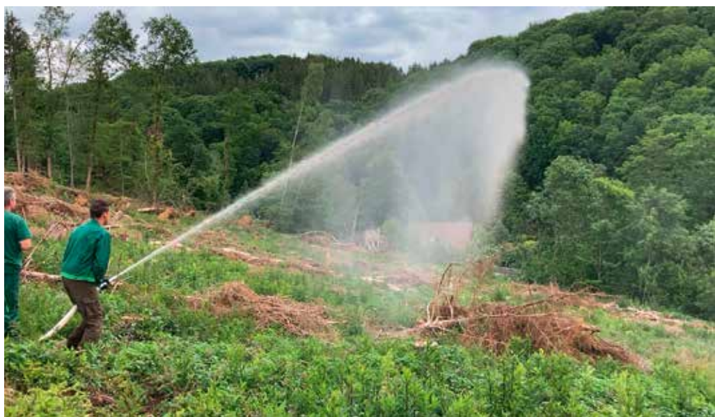
Abb. 3: Anspritzverfahren: Ein Gemisch aus Wasser, Zellulose, Birken- und Douglasiensamen wird auf die Fläche bei Bad Münstereifel gespritzt. Foto: Uwe Schölmerich (2022)
